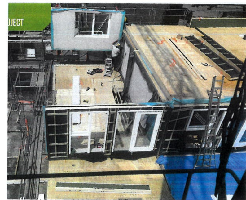
licht hsb-casco komt op de oude fundering.
